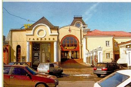
Административно-торговый комплекс «Питерский мостик» в Красноярске
